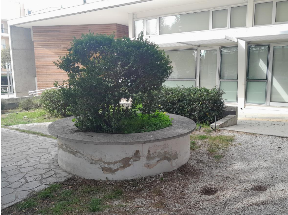
Εικόνα 9-8: Κυκλικό περιτοίχισμα που εξυπηρετεί λεκάνη θάμνου.
