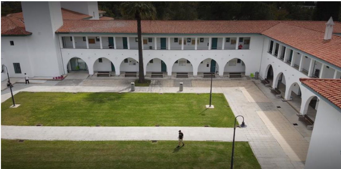
Εικόνα 7-5: Διάδρομοι σε ισόγειο και πρώτο όροφο περίξ της αυλής.
