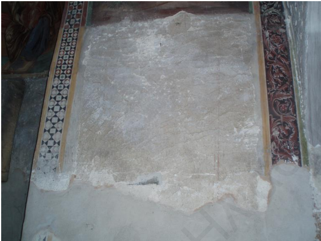
149. Καλοπαναγιώτης, Μονή Αγίου Ιωάννου Λαμπαδιστού, Λατινικό Παρεκκλήσι, ανατολικός τοίχος, λεπτομέρεια από την προετοιμασία στο νοτιοανατολικό τμήμα του
