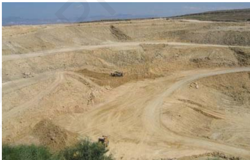
Εικόνα 4.21: Μέτωπο λατόμευσης ασβεσταρενιτικών πετρωμάτων στην περιοχή Ιδαλίου ( http://www.latouros.com/Gallery/gallery_rd.htm ).
