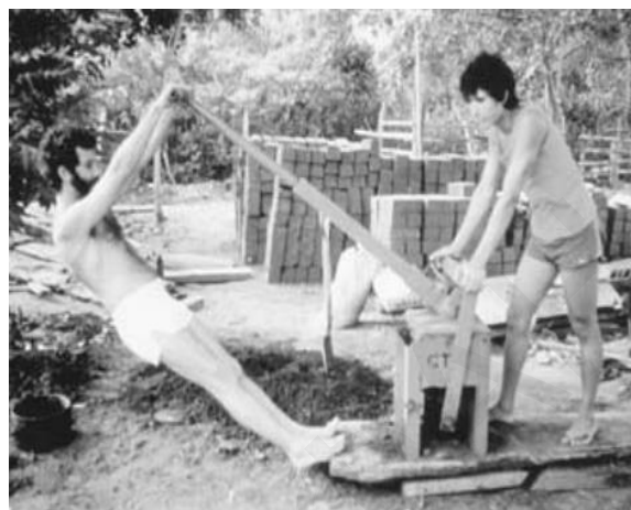
Εικόνα 12: Παραγωγή με χειρωνακτικό τρόπο στην Παραγουάη. Η ανάμιξη της πρώτης ύλης και η απόθεση των συμπιεσμένων ωμοπλίνθων γίνεται δίπλα από την πρέσα (Minke, 2006).
