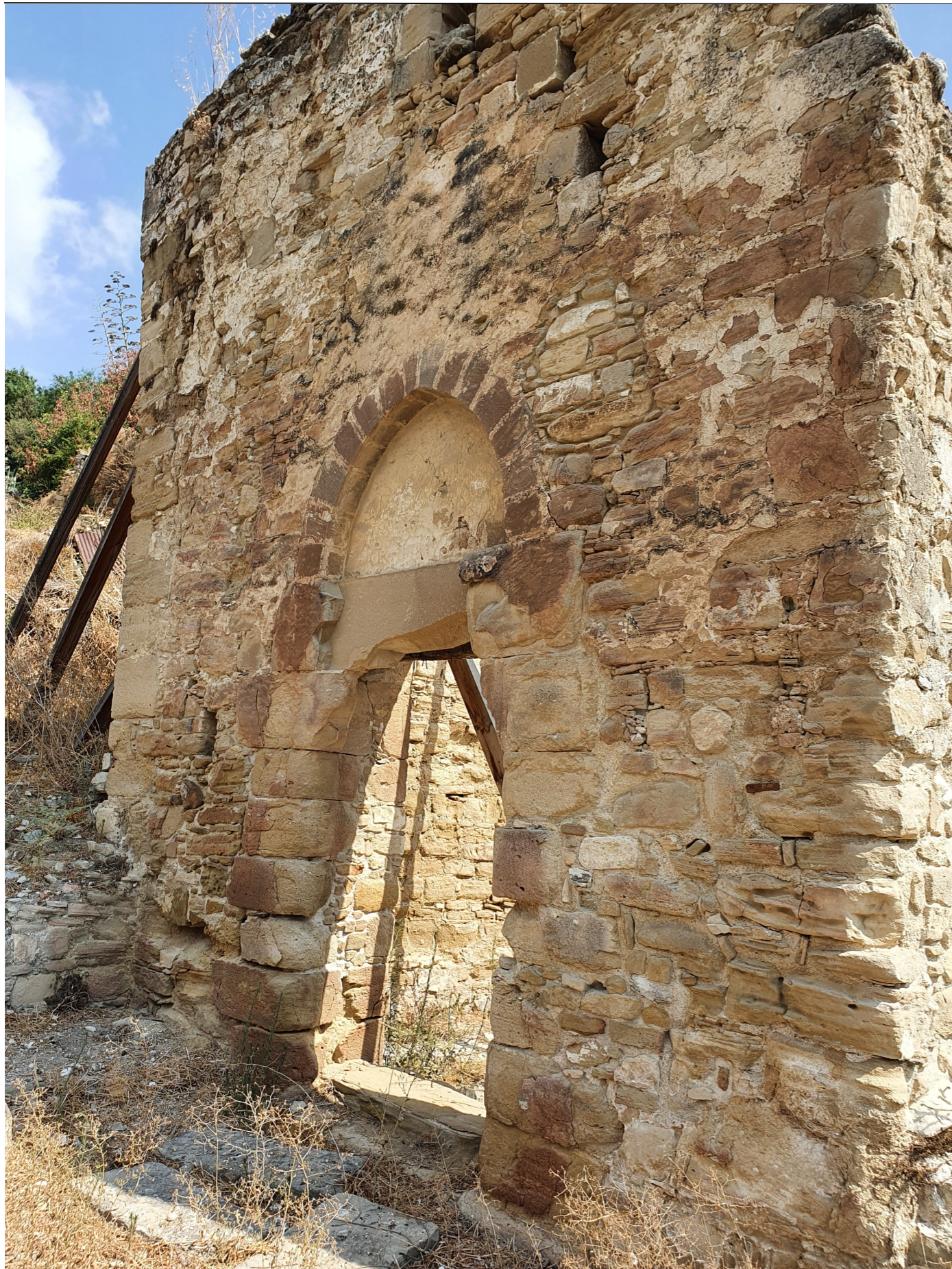
Εικ. 43 Ίχνη επιχρίσματος– δυτική τοιχοποιία
