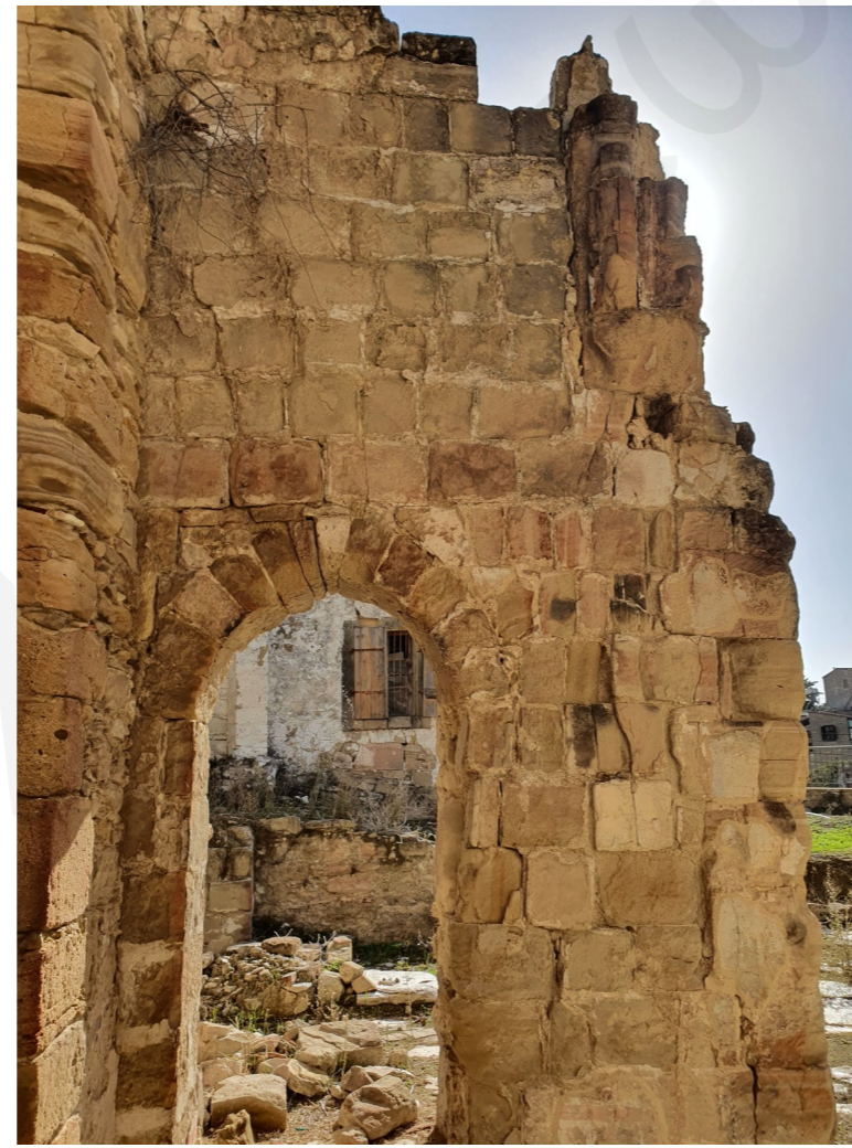
Εικ.34 Δυτική θύρα και κούφωμα άνωθεν της θύρας σε βόρειο ναό
