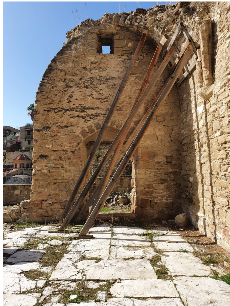
Εικ.33 Δυτική θύρα και κούφωμα άνωθεν της θύρας σε βόρειο ναό
