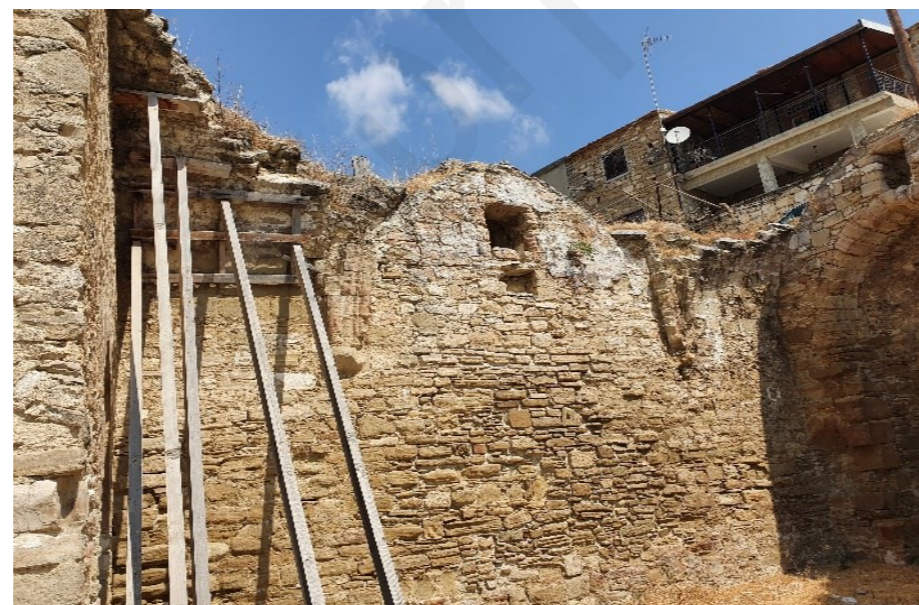
Εικ.30 Βόρεια τοιχοποιία
