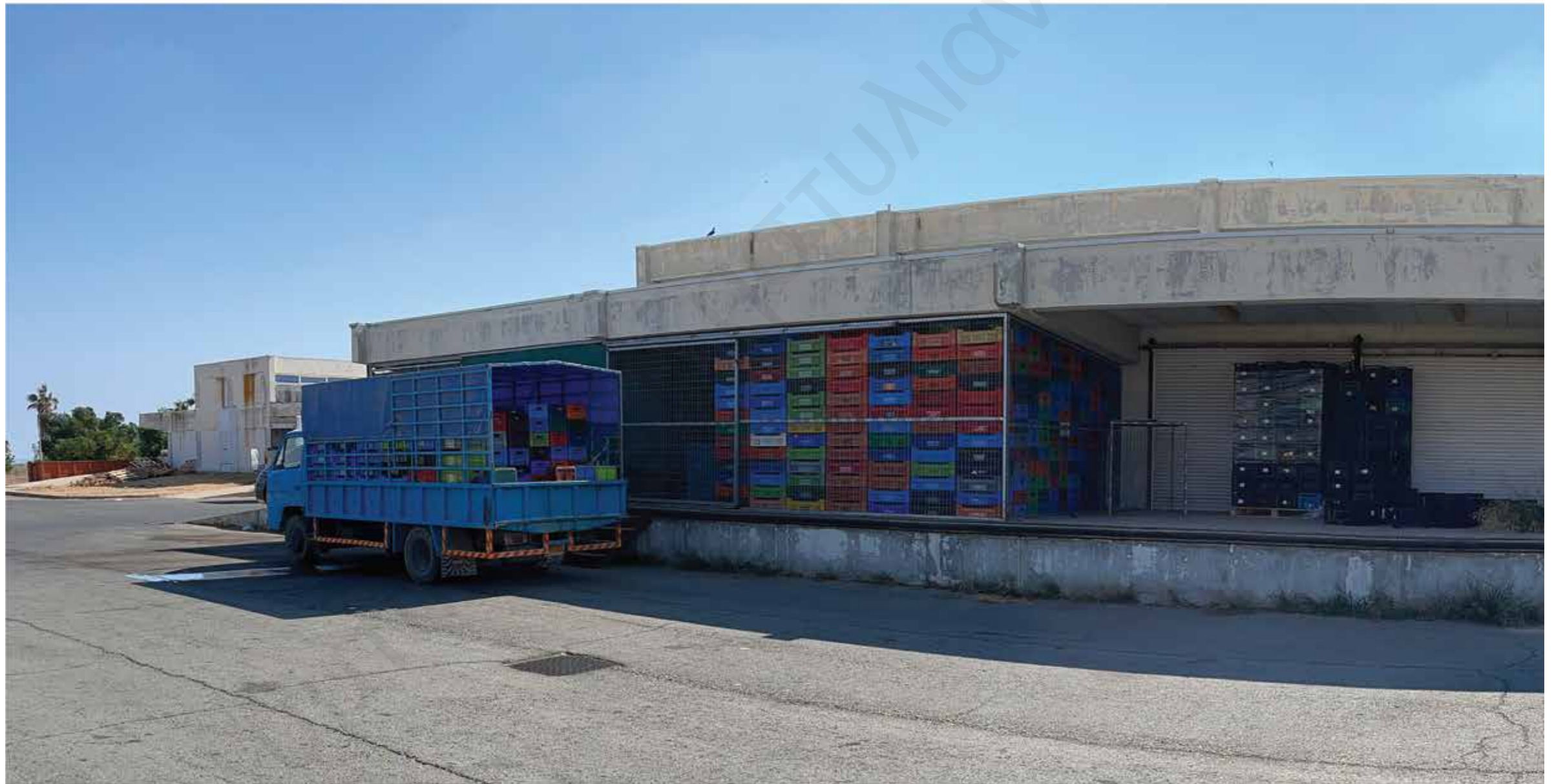
Κενοί Χώροι- Χώροι Αποθήκευσης
