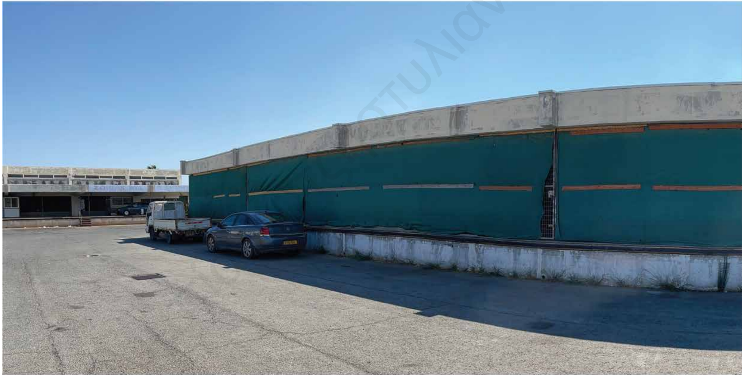
Κενοί Χώροι- Χώροι Αποθήκευσης
