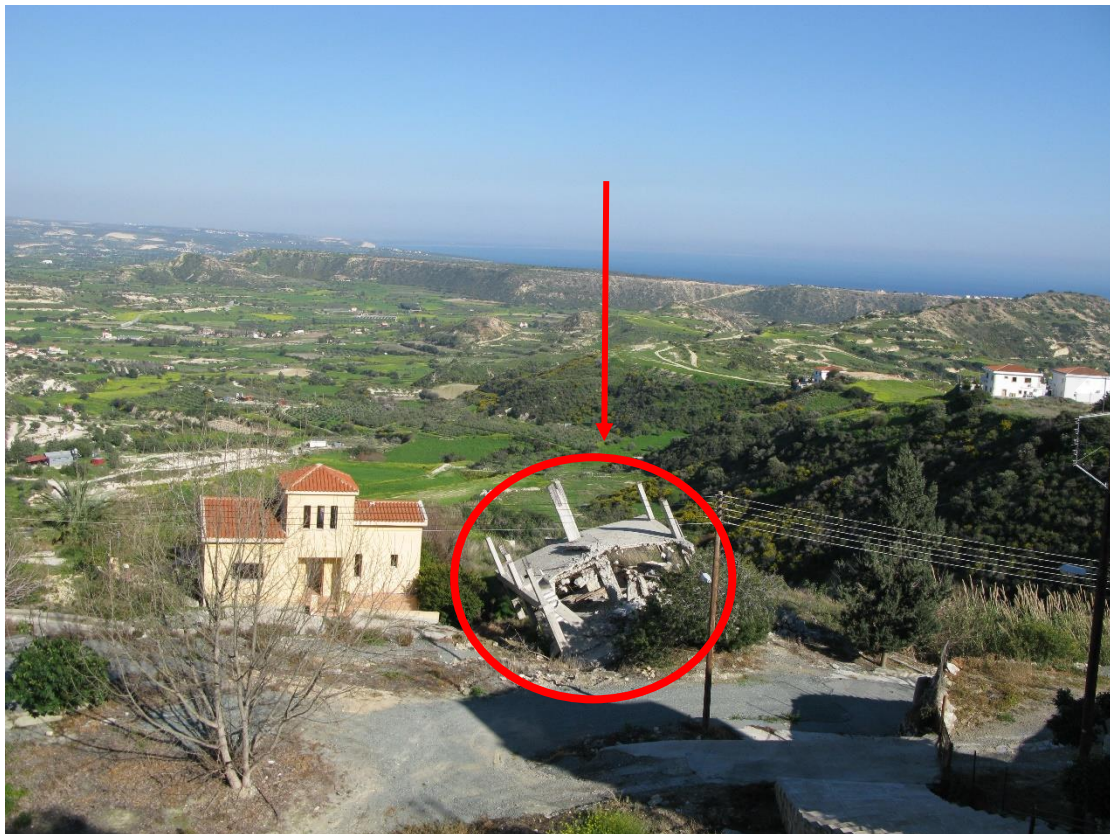
Σχήμα 4: Επηρεαζόμενη κατοικία που έχει πάρει μεγάλη κλίση 10 χρόνια μετά την ενεργοποίηση της κατολίσθησης (2011). Πηγή: Τμ. Γεωλογικής Επισκόπησης
