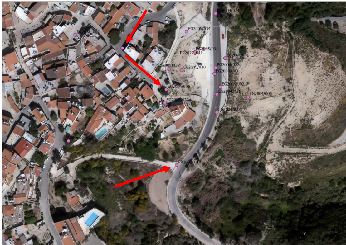
Σχήμα 5: Γεωτρήσεις του ΤΓΕ στην περιοχή της κατολίσθηση. Με κόκκινο βέλος οι 2 στις οποίες υπάρχει αστοχία
