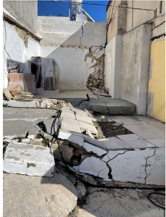
Σχήμα 6&7: Ρωγμές σε κατοικίες μετά την μετακίνηση τον Ιανουάριο 2022. Πηγή: Τμ. Γεωλογικής Επισκόπησης
