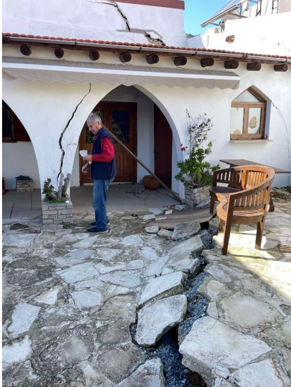
Σχήμα 6&7: Ρωγμές σε κατοικίες μετά την μετακίνηση τον Ιανουάριο 2022. Πηγή: Τμ. Γεωλογικής Επισκόπησης
