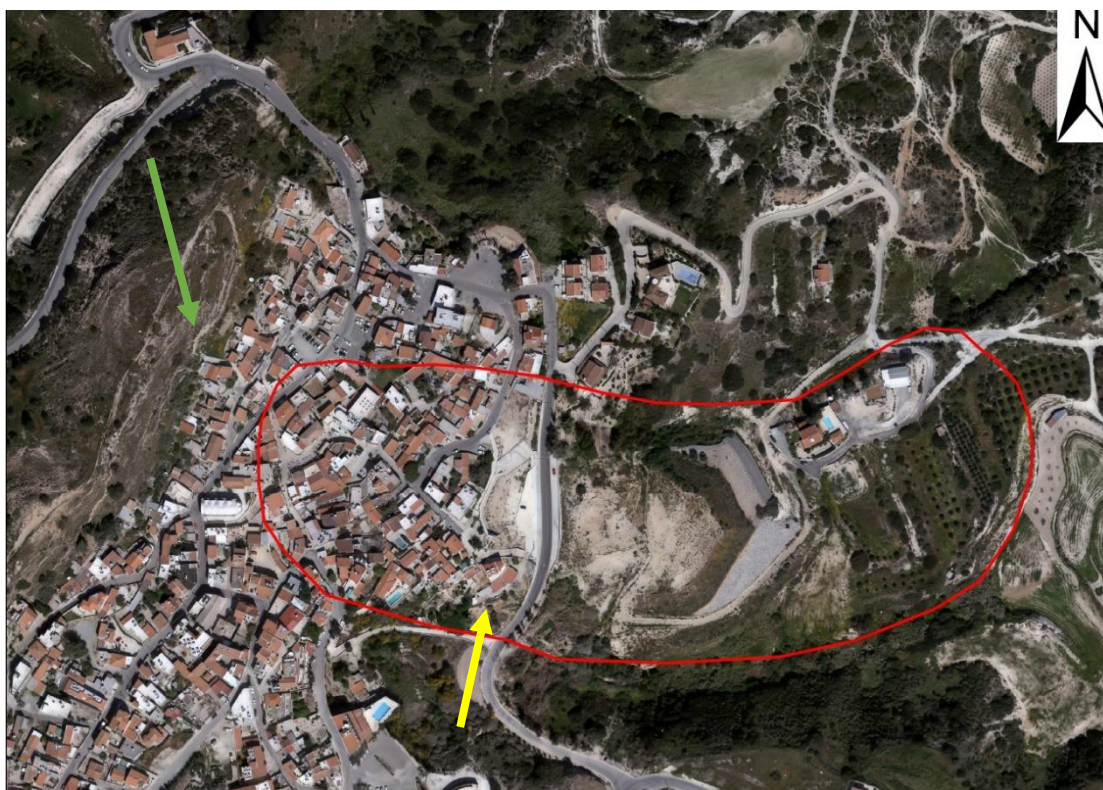
Σχήμα 14: Απεικόνιση των ορίων της παλαιοκατολίσθησης. Το πράσινο βέλος δείχνει το πρηνές στο οποίο υπάρχουν στρώσεις ψαμμίτη και το κίτρινο το σημείο που υπάρχουν κατολισθημένα τεμάχια ψαμμίτη.
