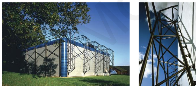
Εικόνα 2.13 Χωρικό πλαισιωτό δικτύωμα: Αθλητικό κέντρο "IBM", Ηνωμένο Βασίλειο [2.62].
