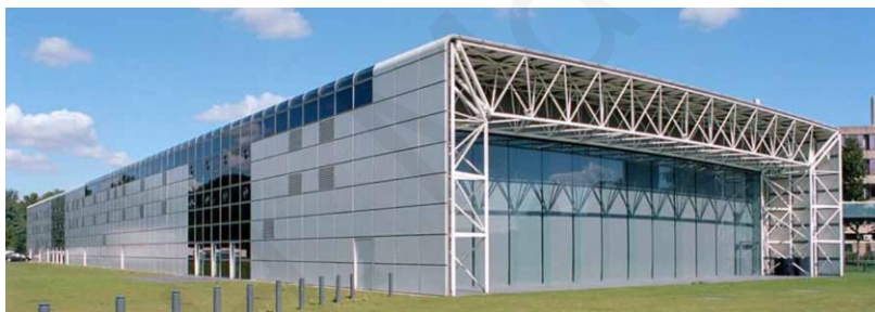
Εικόνα 2.14 Χωροδικτύωμα: Κέντρο εικαστικών τεχνών "Sainsbury", Ηνωμένο Βασίλειο [2.63].
