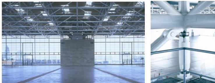
Εικόνα 2.16 Χωροδικτύωμα: Εκθεσιακός χώρος 13, Αννόβερο [2.65].
