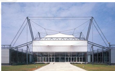
Εικόνα 2.18 Υβριδικό δομικό σύστημα: Ερευνητικό κέντρο Schlumberger, Ηνωμένο Βασίλειο [2.63].
