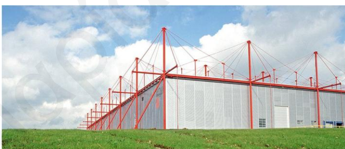
Εικόνα 2.19 Υβριδικό δομικό σύστημα: Εργοστασιακός χώρος Fleetguard, Γαλλία [2.63].
