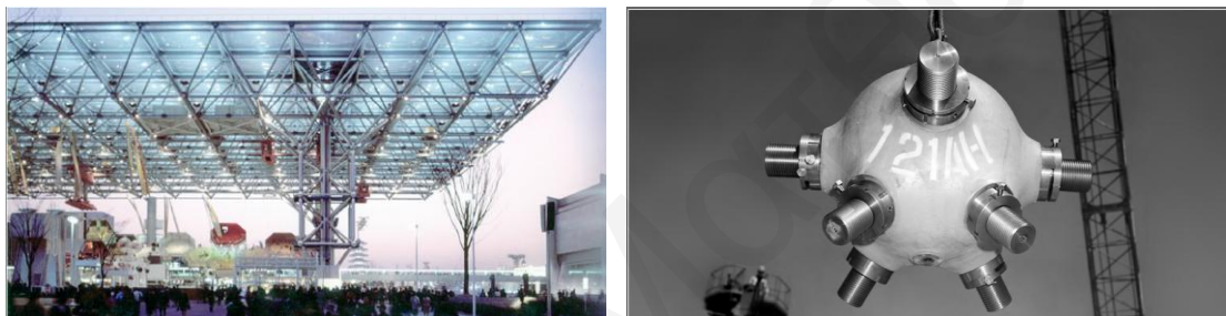
Εικόνα 2.15 Χωροδικτύωμα: Ετήσια έκθεση 1970, Οσάκα [2.64].
