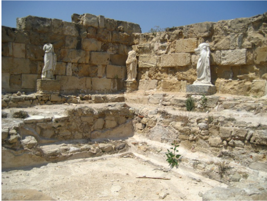
Εικ. 121: Ψευδοϊσόδομο σύστημα λιθοδομής, βόρεια nataatio στο λουτρό-γυμνάσιο, Σαλαμίνα (Ελισάβετ Στεφανή).
