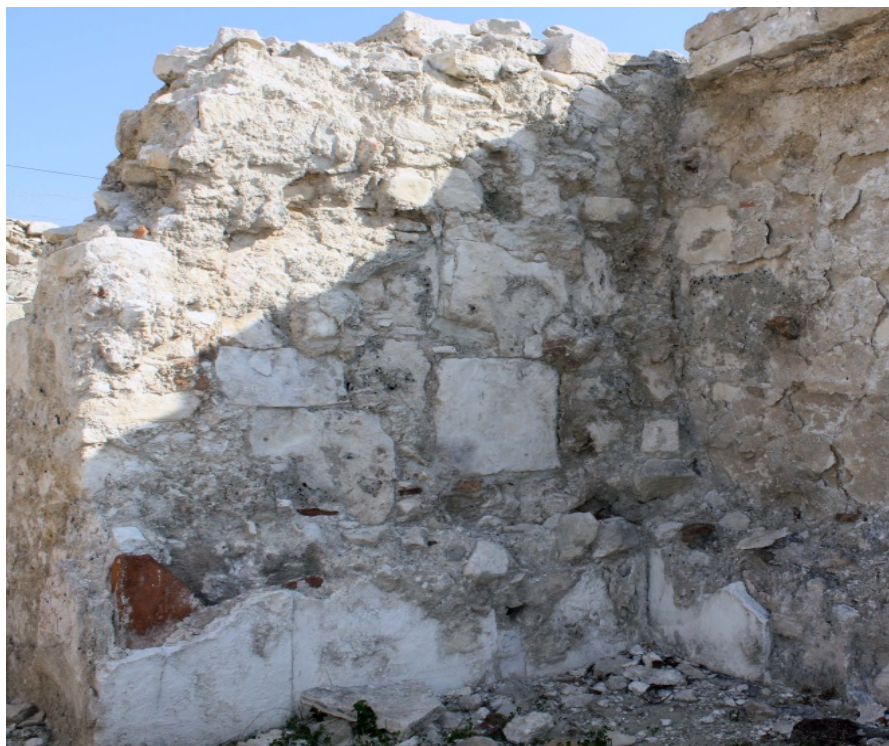
Εικ. 110: Αργολιθοδομή, tepidarium λουτρού αγοράς, Αμαθούντα (Σκεύη Χριστοδούλου).
