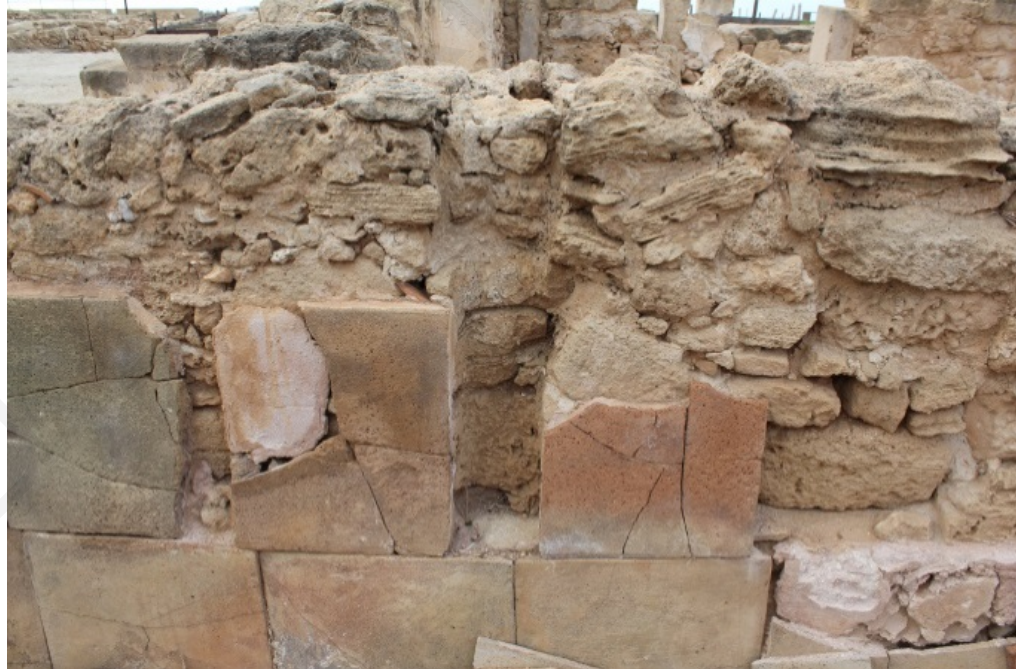
Εικ. 194: Τετράγωνος αεραγωγός στο δυτικό τοίχο του caldarium , λουτρό της Οικίας του Ορφέα, Νέα Πάφος (Σκευή Χριστοδούλου).
