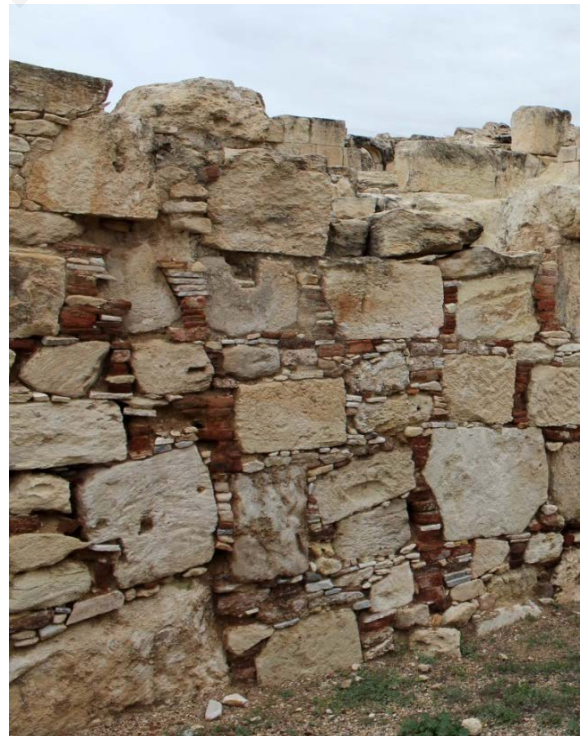
Εικ. 125: Ψευδοϊσόδομο σύστημα λιθοδομής (σκάλα), tepidarium ανατολικής πτέρυγας θερμών, Κούριο (Σκεύη Χριστοδούλου).
