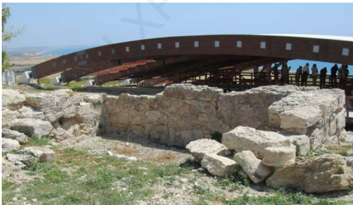
Εικ. 208: Ημι-κατεστραμμένη υδατοδεξαμενή βορείως των λουτρών στο Παράρτημα του Ευστολίου, Κούριο (Σκεύη Χριστοδούλου).
