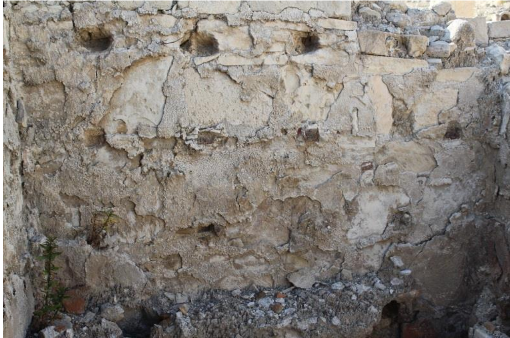
Εικ. 154: Εσοχές για την τοποθέτηση πήλινων εμβόλων, νότιος τοίχος tepidarium , λουτρό αγοράς, Αμαθούντα (Σκεύη Χριστοδούλου).
