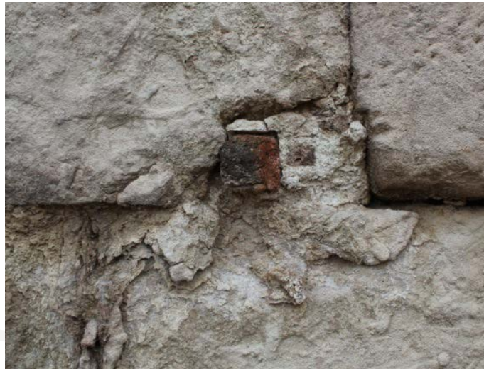
Εικ. 184: Θραύσματα δύο πήλινων εμβόλων, δυτικός τοίχος caldarium , δυτική πτέρυγα θερμών, ακρόπολη Κουρίου (Σκευή Χριστοδούλου).
