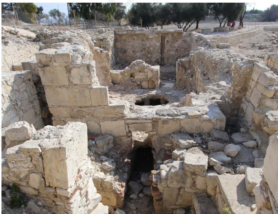
Εικ. 111: Ορθογώνιο ισόδομο σύστημα λιθοδομής, εξωτερικό μέτωπο caldarium , λουτρό αγοράς στην Αμαθούντα (Σκεύη Χριστοδούλου).
