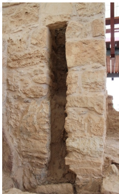
Εικ. 162: Αεραγωγός στο νότιο τοίχο του sudatorium , λουτρό δίπλα στο Ιερό του Απόλλωνα Υλάτη, Κούριο (Σκεύη Χριστοδούλου).
