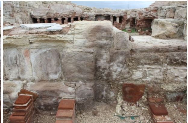
Εικ. 178: Αεραγωγοί, tepidarium ανατολικής πτέρυγας θερμών, ακρόπολη Κουρίου (Σκεύη Χριστοδούλου).
