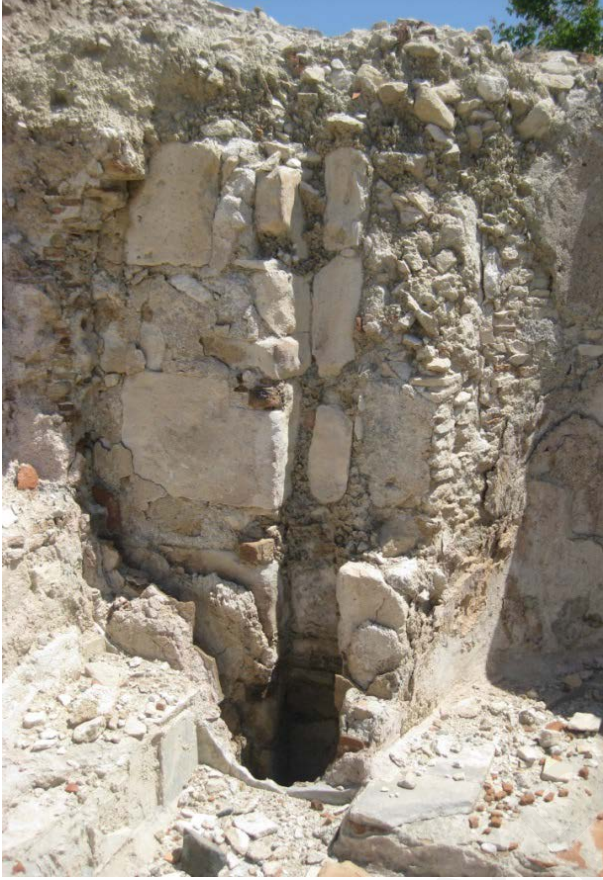
Εικ. 152: Αεραγωγός στο δυτικό τοίχο του caldarium , λουτρό αγοράς, Αμαθούντα (Σκευή Χριστοδούλου).
