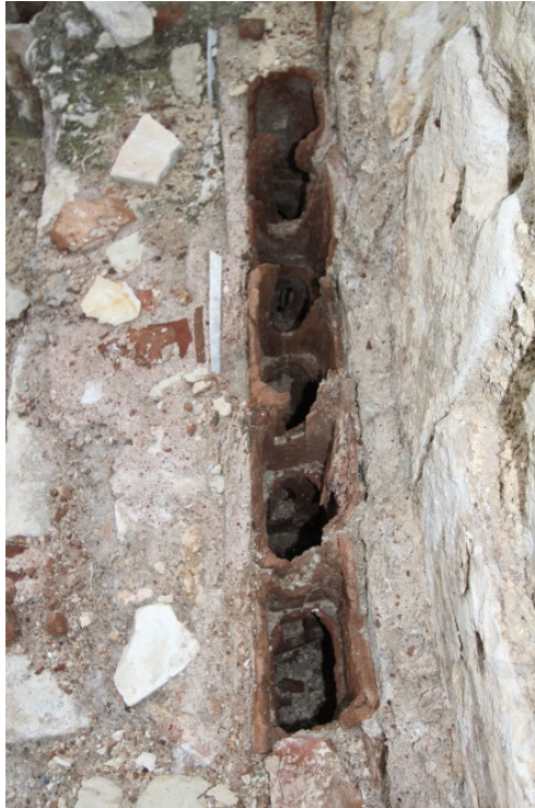
Εικ. 181: Tubuli στο tepidarium , ανατολική πτέρυγα θερμών, ακρόπολη Κουρίου (Σκευή Χριστοδούλου).
