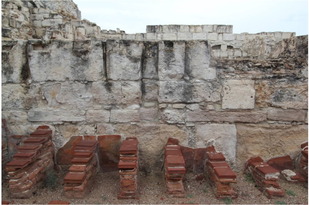
Εικ. 174: Αεραγωγοί στο caldarium , δυτική πτέρυγα θερμών, ακρόπολη Κουρίου (Σκευή Χριστοδούλου).
