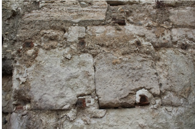
Εικ. 183: Θραύσμα πήλινων εμβόλων, δυτικός τοίχος caldarium , δυτική πτέρυγα θερμών, ακρόπολη (Σκευή Χριστοδούλου).
