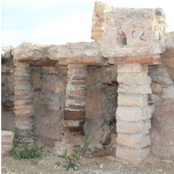
Εικ. 202: Τετράγωνη pila , caldarium λουτρού στην Έπαυλη του Θησέα, Νέα Πάφος (Σκευή Χριστοδούλου).
