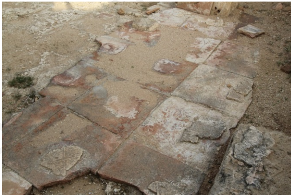
Εικ. 90: Επίστρωση δαπέδου με κεραμικές πλάκες, λουτρό νοτίως της Έπαυλης του Θησέα, Νέα Πάφος (Σκεύη Χριστοδούλου).
