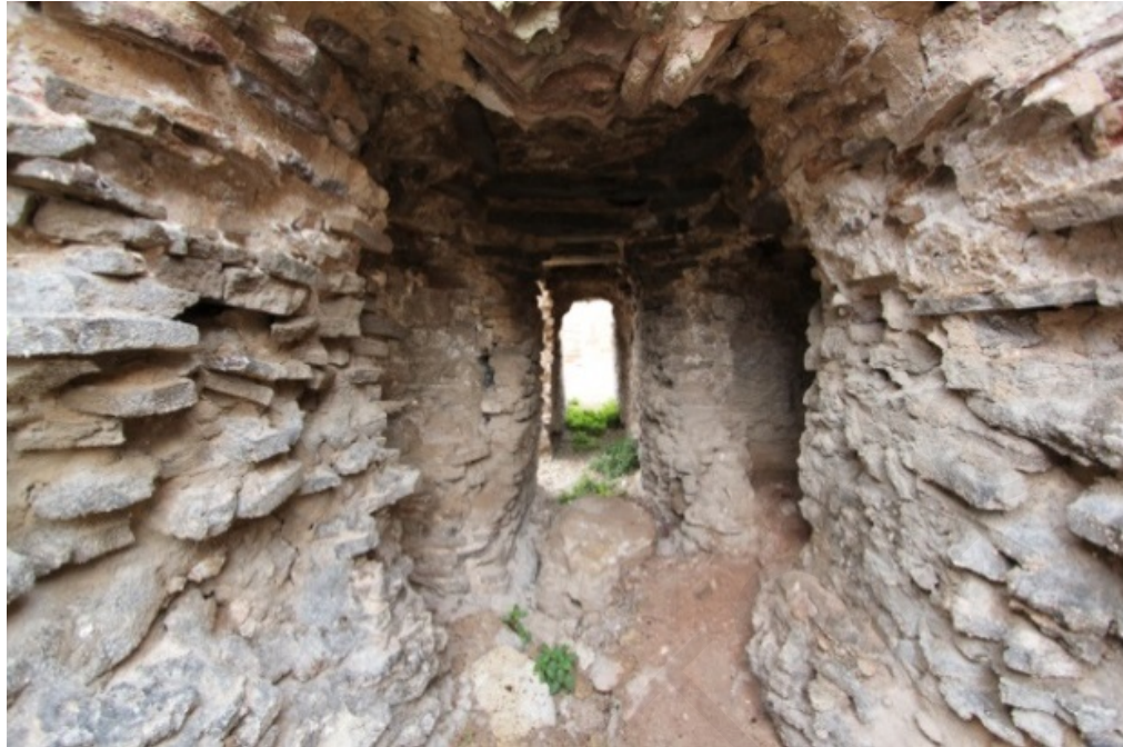
Εικ. 176: Σημάδια καύσης στο ανατολικό praefurnium , ανατολική πτέρυγα θερμών, ακρόπολη Κουρίου (Σκεύη Χριστοδούλου).
