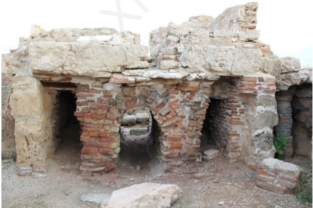
Εικ. 201: Πλινθόκτιστο αμυδωτό άνοιγμα (όψη από caldarium ), λουτρά στην Έπαυλης του Θησέα, Νέα Πάφος (Σκευή Χριστοδούλου).
