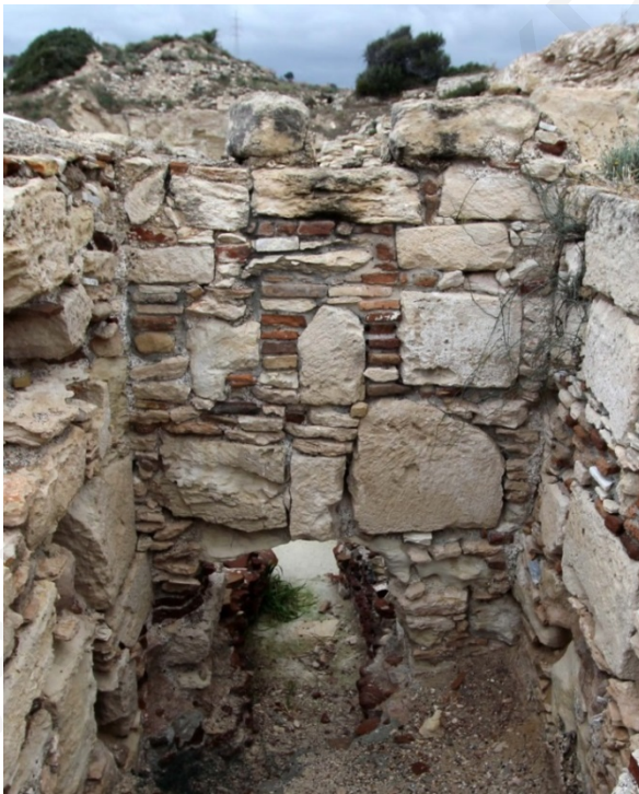
Εικ. 124: Ψευδοϊσόδομο σύστημα λιθοδομής (σκάλα), λουτρό στην Οικία των Μονομάχων, Κούριο (Σκεύη Χριστοδούλου).
