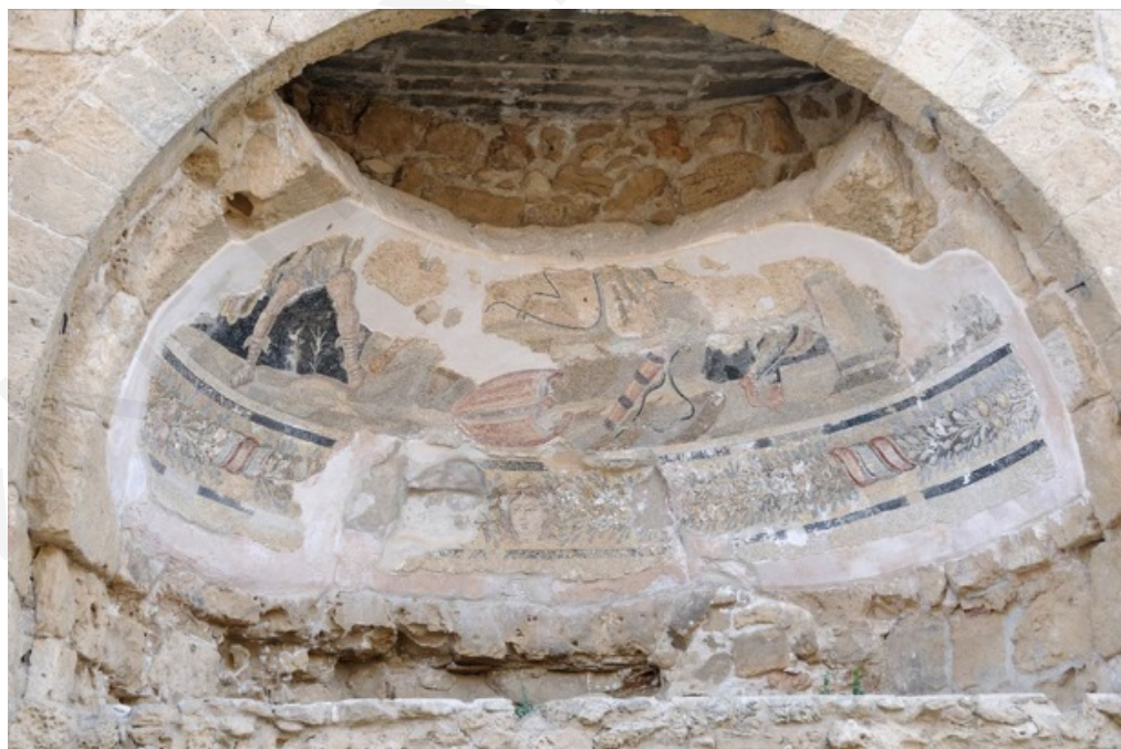
Εικ. 39: Κόγχη, νότιος τοίχος νότιου sudatorium , λουτρό-γυμνάσιο Σαλαμίνα (Ελισάβετ Στεφανή).
