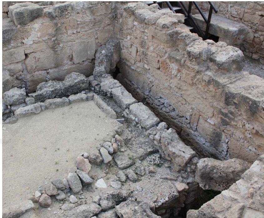
Εικ. 122: Ψευδοϊσόδομο σύστημα λιθοδομής, αποχωρητήρια Έπαυλης Θησέα (Σκεύη Χριστοδούλου).
