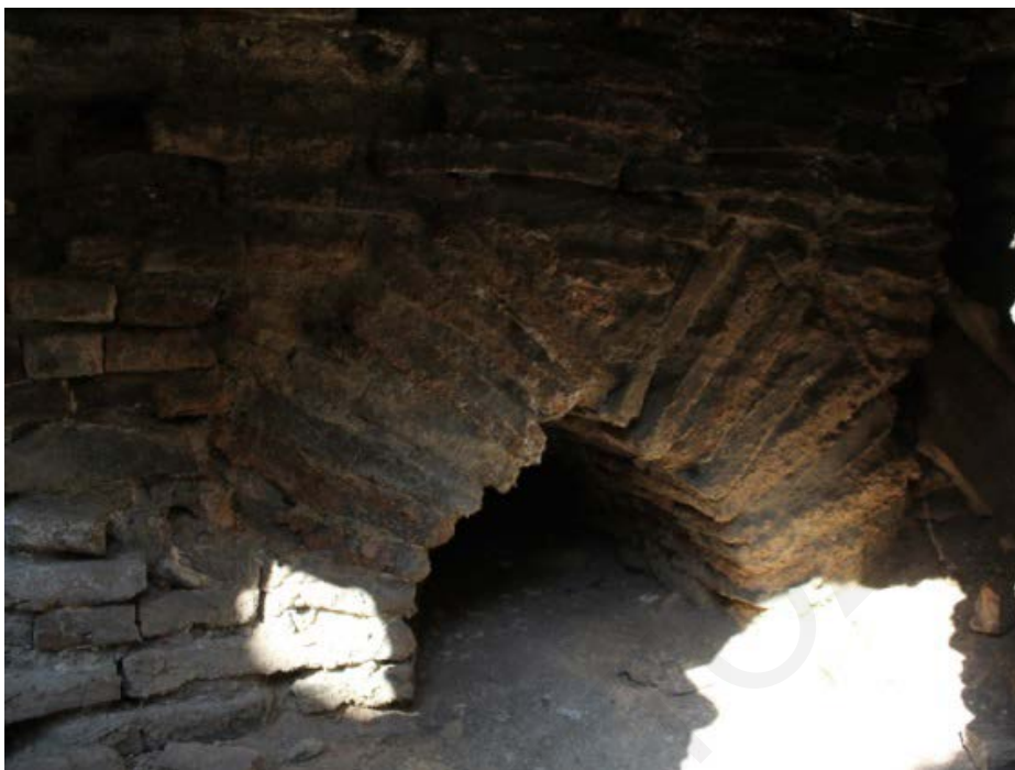
Εικ. 150: Πλινθόκτιστο αψιδωτό άνοιγμα υποκαύστου, λουτρό αγοράς, Αμαθούντα (Σκεύη Χριστοδούλου).
