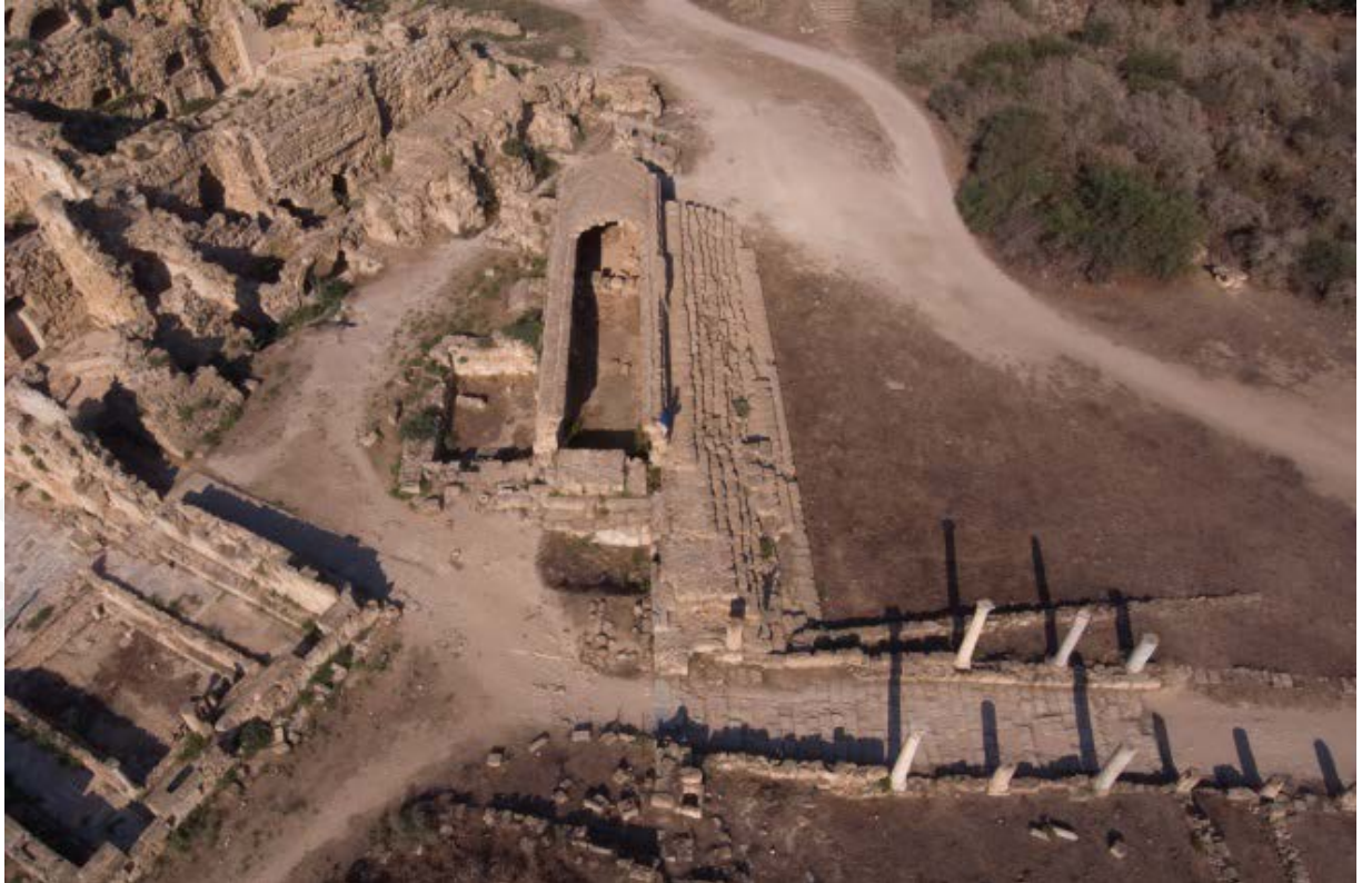
Εικ. 213: Αεροφωτογραφία ορθογώνιας θολωτής και τετράγωνης δεξαμενής νοτίως του
