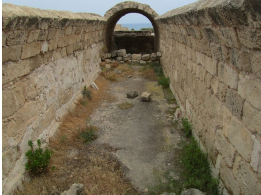
Εικ. 214: Εσωτερική όψη θολωτής δεξαμενής, Σαλαμίνα (Ελισάβετ Στεφανή).
