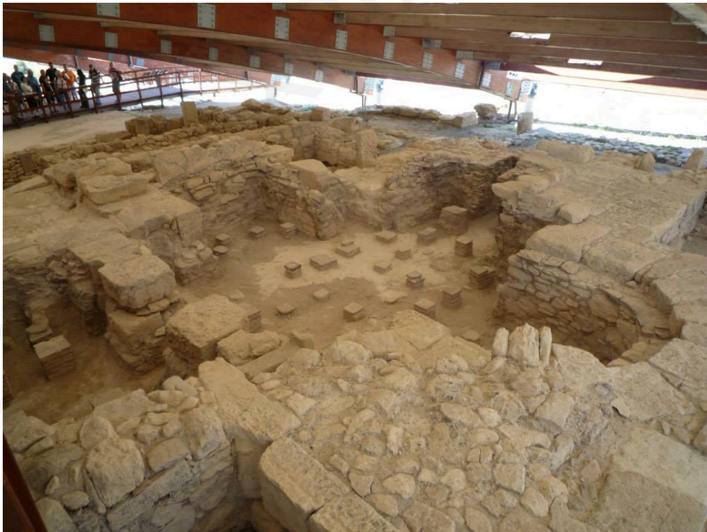
Εικ. 118: Μεγάλοι πελεκητοί ασβεστόλιθοι στο ανώτερο μέρος της λιθοδομής, caldarium στα λουτρά στο Παράρτημα του Ευστολίου (Σκευή Χριστοδούλου).
