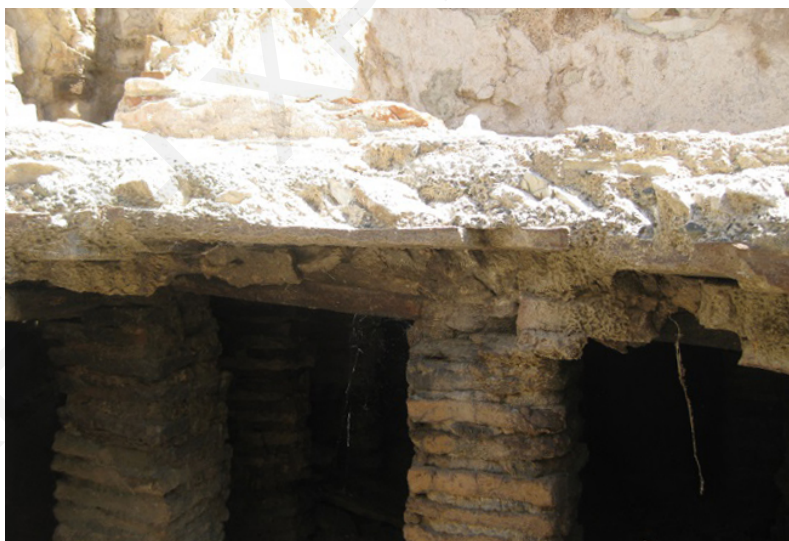
Εικ. 151: Suspensura , λουτρό αγοράς, Αμαθούντα (Σκεύη Χριστοδούλου).
