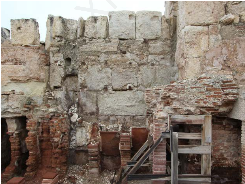
Εικ. 182: Τμήμα πήλινων εμφόλων στο δυτικό τοίχο του caldarium , δυτική πτέρυγα θερμών, ακρόπολη Κουρίου (Σκευή Χριστοδούλου).
