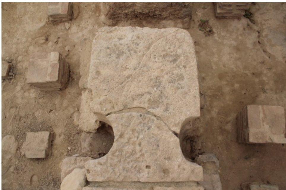
Εικ. 188: Λάξευση λίθου για την τοποθέτηση αγωγών κυκλικής διατομής, caldarium λουτρών στο Παράρτημα του Ευστολίου, Κούριο (Σκεύη Χριστοδούλου).
