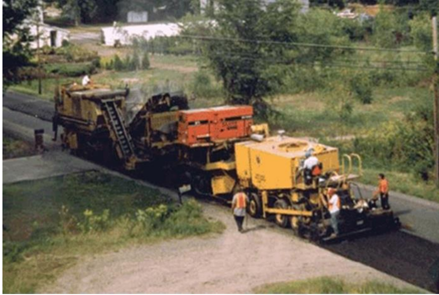
Εικόνα 3: Ψυχρή επιτόπου ανακύκλωση ασφαλτικού οδοστρώματος.
