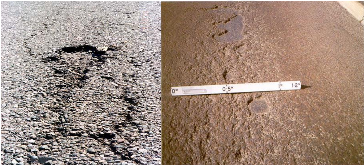
Εικόνα 12: Αποκόλληση αδρανών (Raveling).
