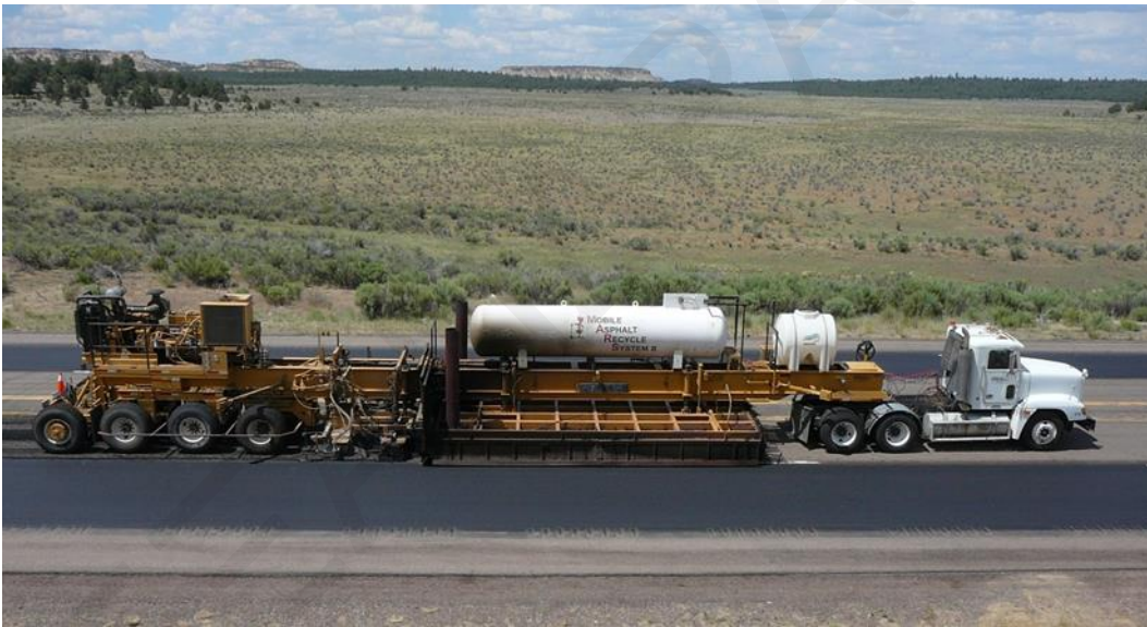
Εικόνα 2: Επιτόπου θερμή ανακύκλωση
