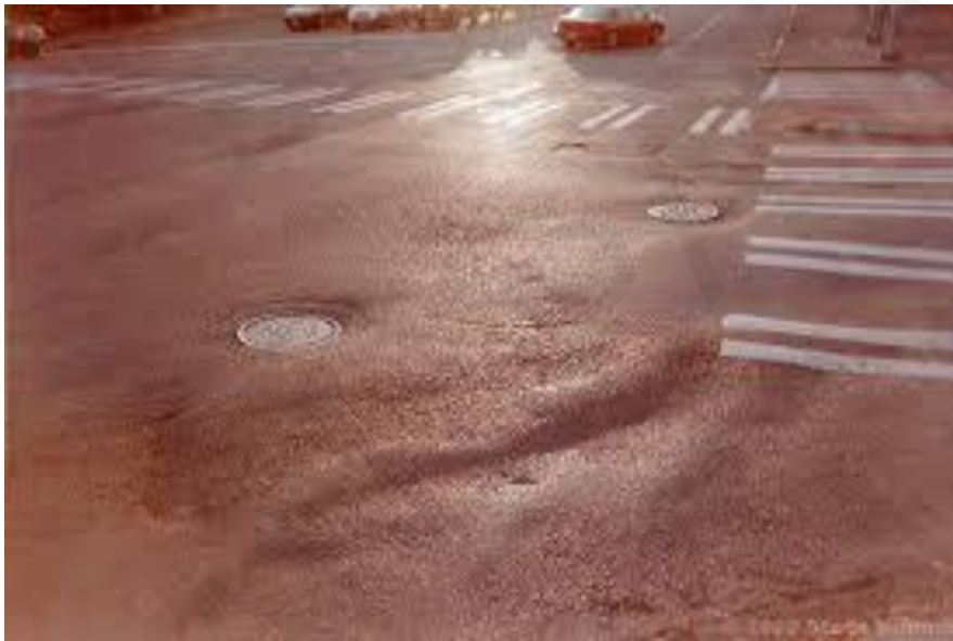
Εικόνα 8: Πτυχώσεις και κυματοειδής σχηματισμός.
