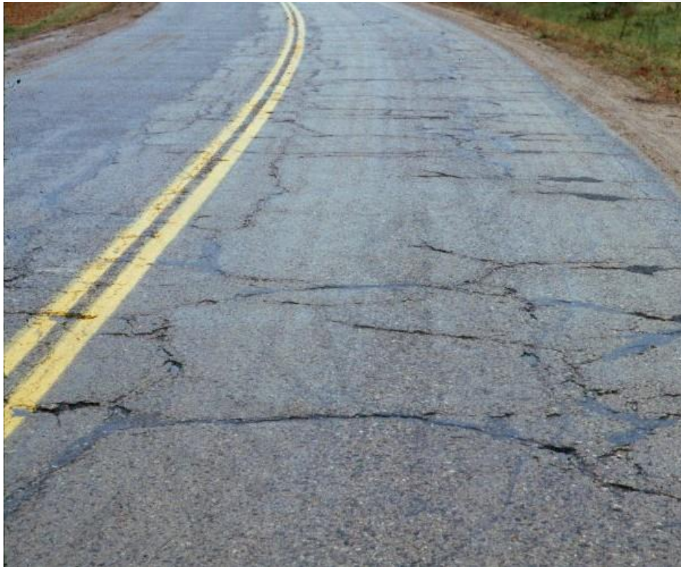
Εικόνα 7: Block cracking.
