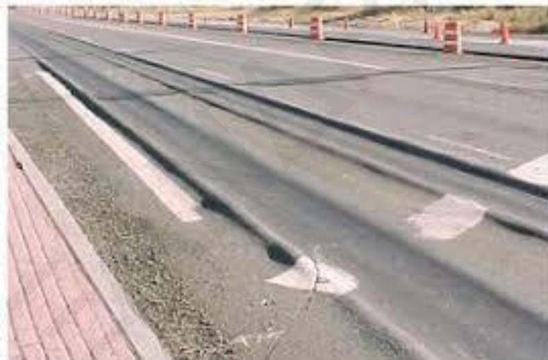
Εικόνα 13: Τροχοαυλάκωση (Rutting).
