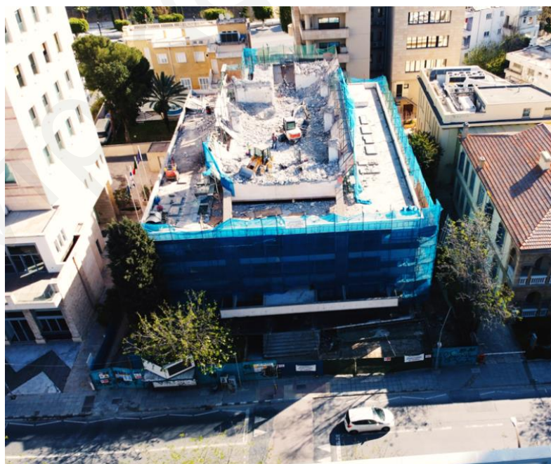
Εικόνα 1: Κτήριο υπό κατεδάφιση
