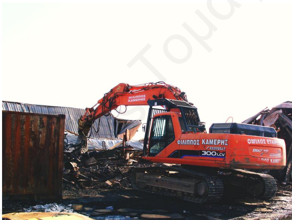
Εικόνα 3: Κατεδάφιση με μηχανικά μέσα
