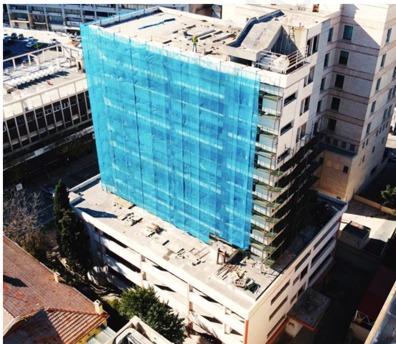
Εικόνα 5: Πολυώροφο κτήριο προς κατεδάφιση στο κέντρο της Λευκωσίας
