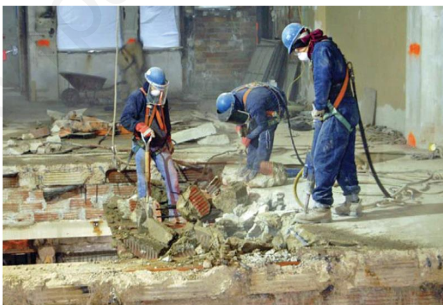
Εικόνα 2: Κατεδάφιση δια χειρός (Νομικού, 2011) [2]
