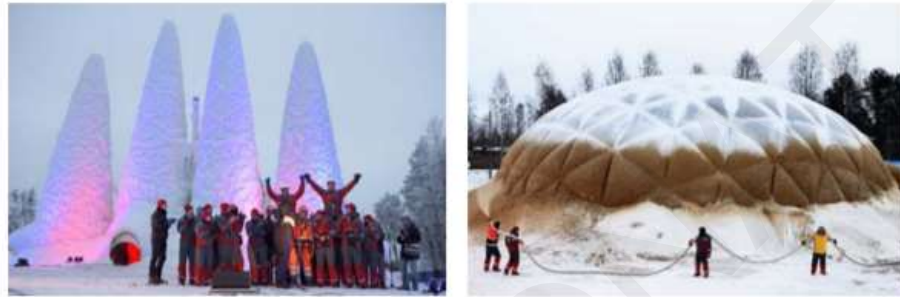
Εικόνα 19: Χρήση πνευματικών καλουπιών σε μεγάλης κλίμακας κατασκευές (Pronk, 2014; Kokawa, 2012)
