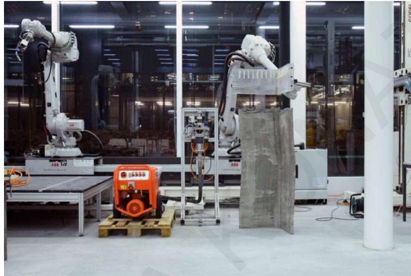
Εικόνα 16: Μέθοδος slipforming για την παραγωγή γραμμικών κατακόρυφων δομικών στοιχείων [8]
