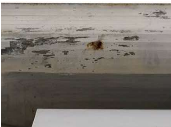
Εικόνα 3.9: Εμφάνιση κηλίδων σκουριάς
