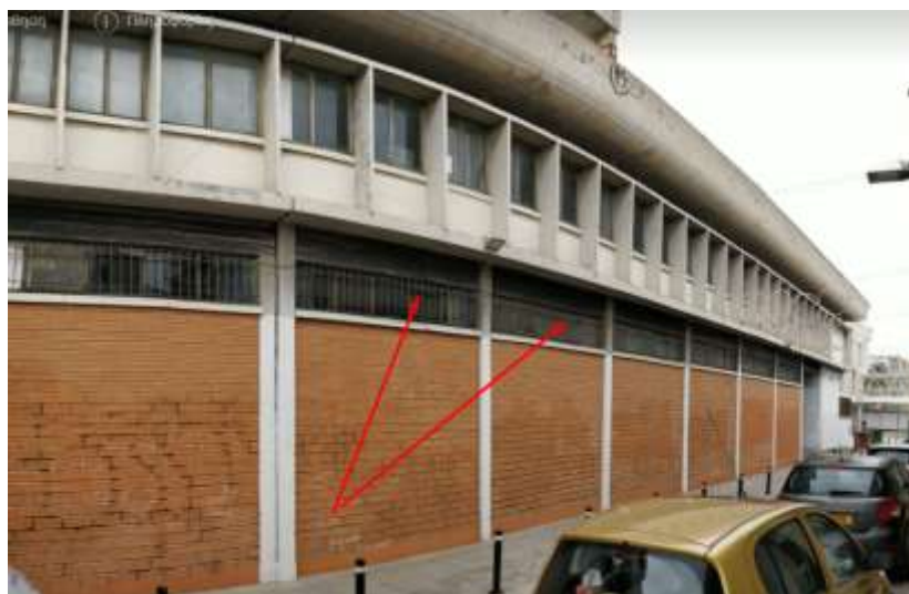
Εικόνα 3.23: Μερικού ύψους τοιχοπληρώσεις μεταξύ των υποστυλωμάτων
