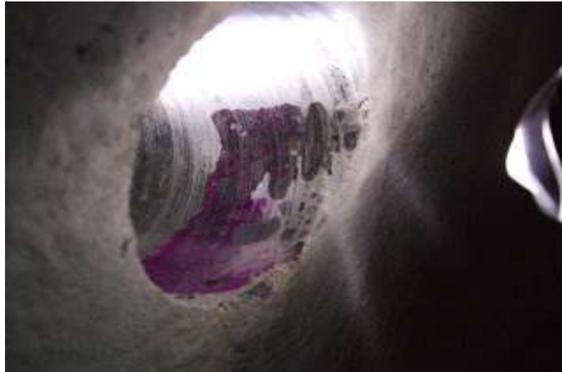
Εικόνα 3.26: Καθορισμός του βάθους ενανθράκωσης
