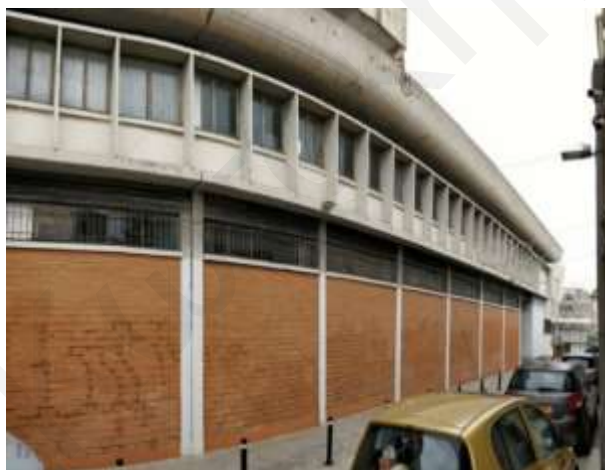
Εικόνα 3.20: Τoiχοπλήρωση περιμετρικά του κτιρίου
