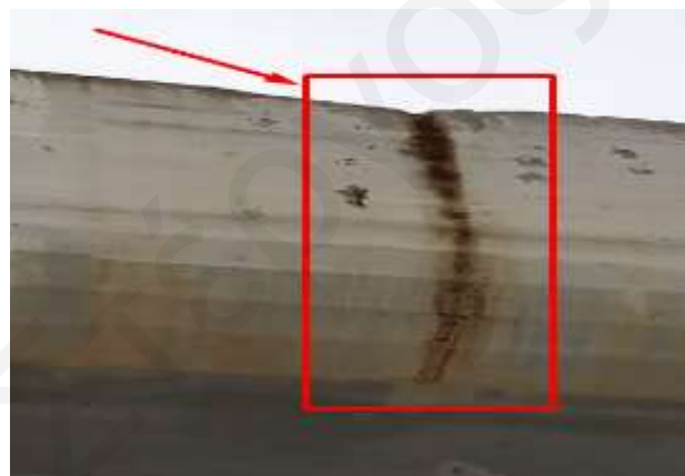
Εικόνα 3.10: Εμφάνιση κηλίδων σκουριάς
