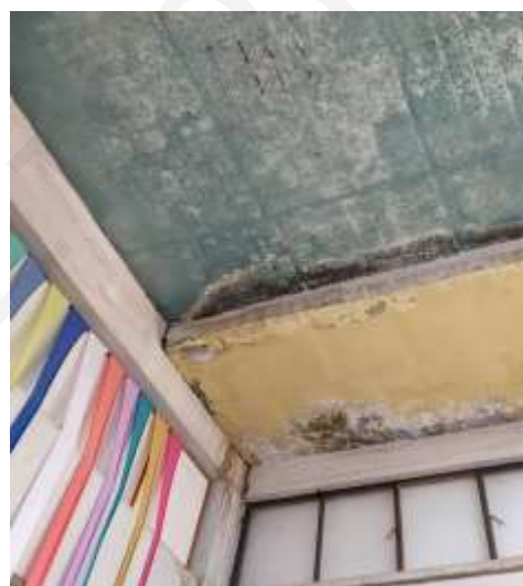
Εικόνα 3.16: Κακή επικάλυψη στο κάτω μέρος της πλάκας και εμφάνιση του σπλισμού - Έντονη υγρασία
