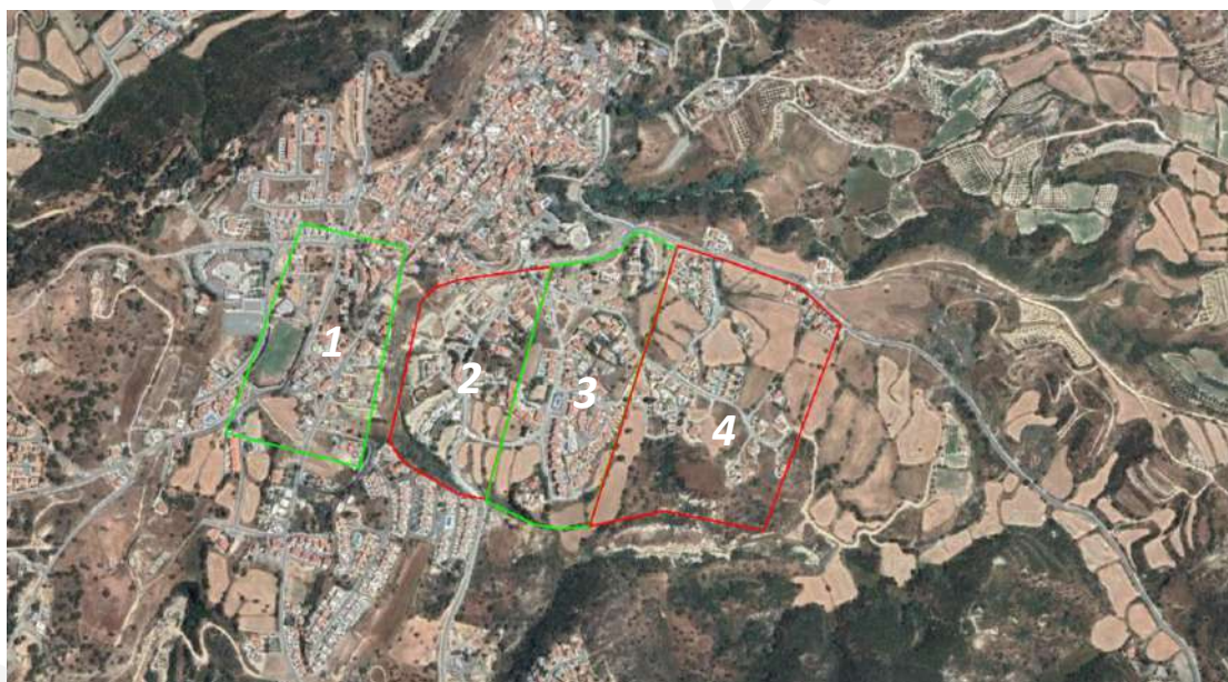
Σχήμα 3.18. Διαχωρισμός της περιοχής μελέτης σε πολύγωνα για τον υπολογισμό των ισοδύναμων φορτίων των κτισμάτων.
