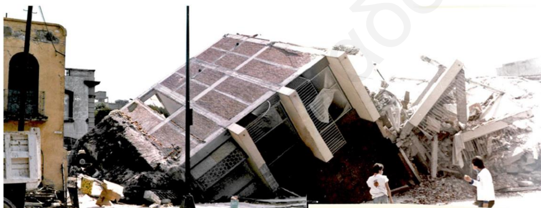
Εικόνα 5: Ανατροπή οκταώροφου κτιρίου θεμελιωμένο σε πασσάλους τριβής κατά το σεισμό της Πόλης του Μεξικού του 1985 (από Auvinet, 2018).
