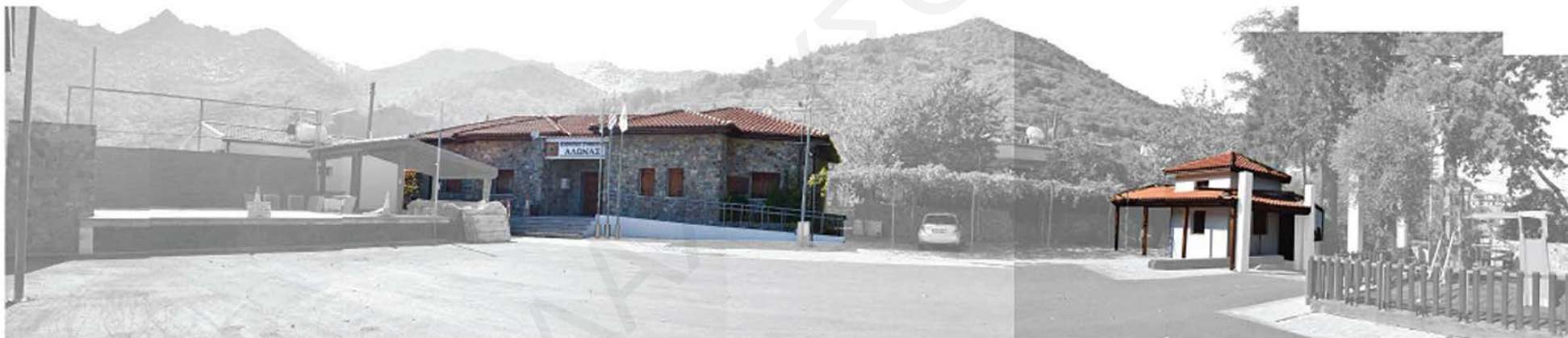
Κτηριακές Υποδομές_Δημόσια Κτήρια Χωριού_Κοινοτικό Συμβούλιο Αλωνας & Ταχυδρομείο
