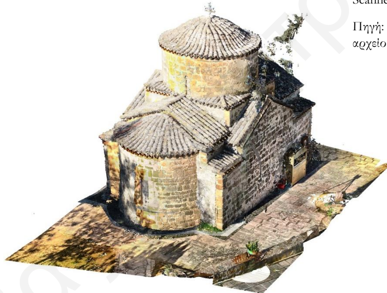
Εικ.8 Νέφος Σημείων από σάρωση με Laser Scanner
