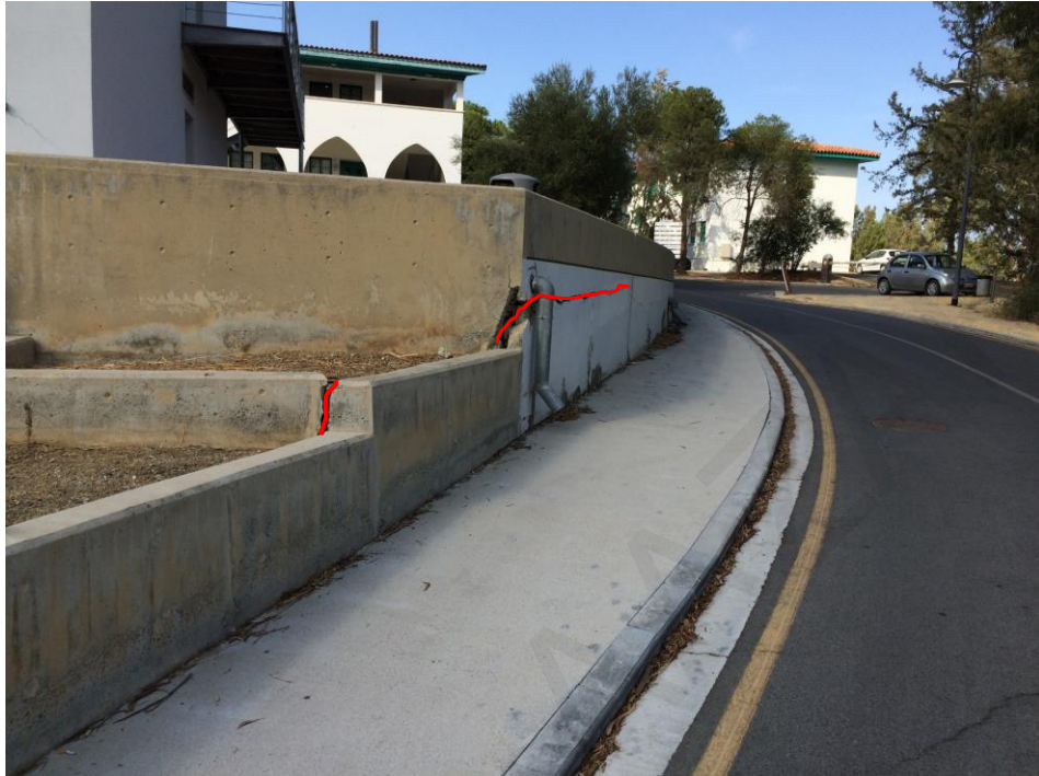
Σχήμα Α.1: Αστοχίες τοιχίων στο παλιό campus του Πανεπιστημίου Κύπρου.
