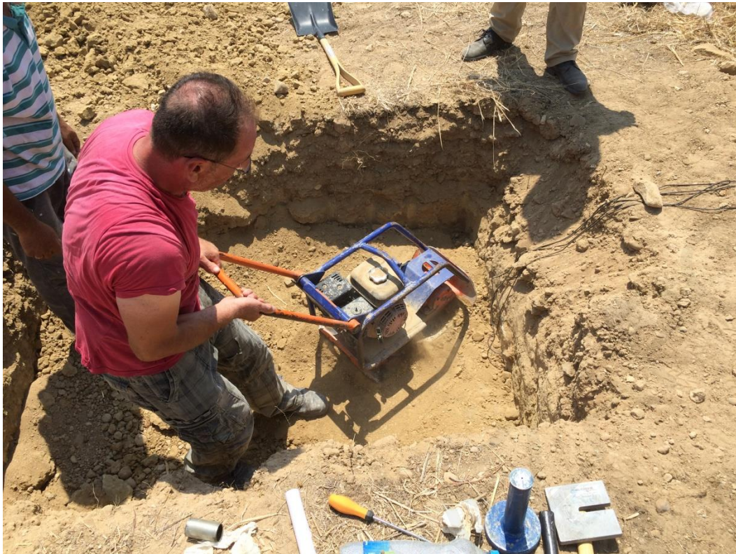
Σχήμα 6.2: Συμπύκνωση εδαφικού υλικού του σκάμματος.
