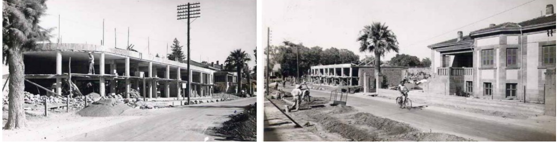
Εικόνα 3.2: Οικοδομή για την ανέγερση του κτιρίου, δίπλα στο σπίτι των αδελφών Μαγκοϊάν
