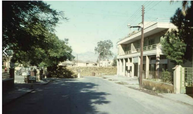
Εικόνα 3.3: Οδοφράγματα εκατέρωθεν του κτιρίου
